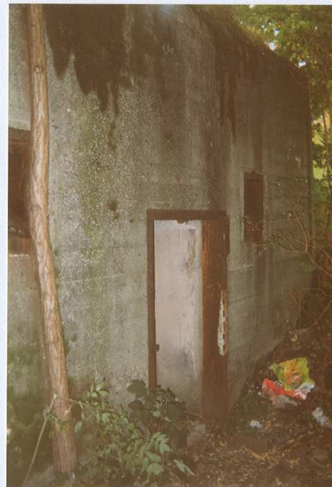
Partia wschodnia z otworem wejściowym i wylotami kanałów wentylacyjnych
