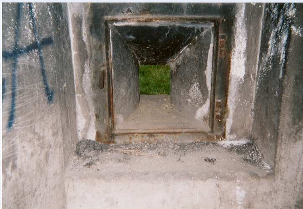
Strzelnica obrony wejścia. Widok od strony wewnętrznej
