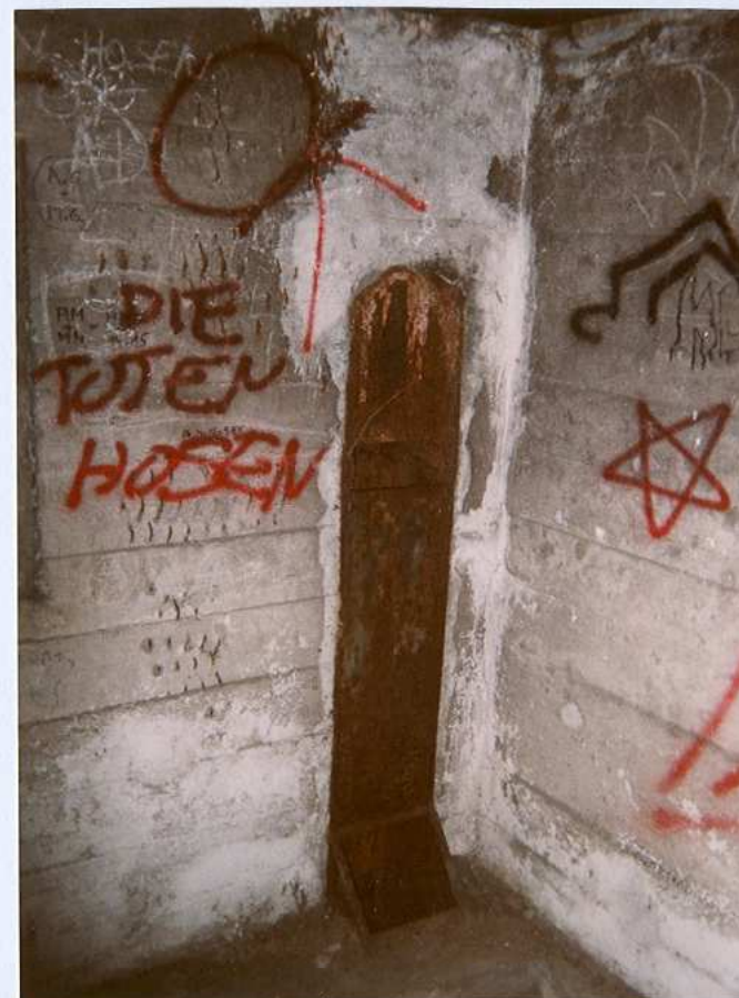
Izba bojowa „h”. Obudowa kanału wentylacyjnego
