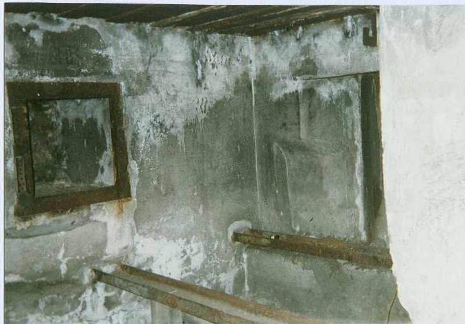
Izba bojowa „g”. Wyjście zapasowe oraz stalowa konstrukcja w podstawie armaty p.panc Izba bojowa „h”. Strzelnica rkm
