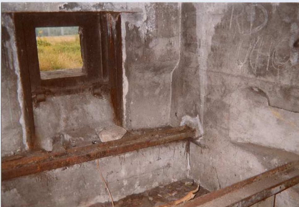
Izba bojowa „g”. Strzelnica armaty p.panc oraz stalowa konstrukcja w podstawie Izba bojowa „h”. Strzelnica ckm
