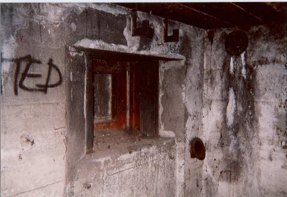
Izba bojowa „g”. Strzelnica armaty p.panc oraz stalowa konstrukcja w podstawie Izba bojowa „h”. Strzelnica ckm
