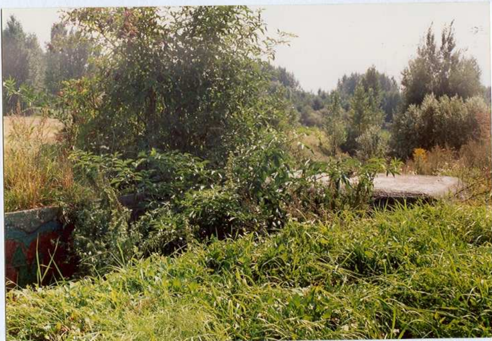
Widok od pn. na partię pozorną i stropową schronu
