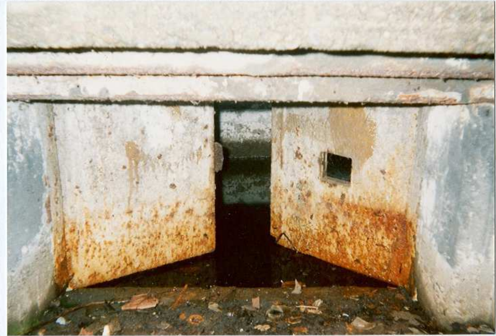
Partia bojowa. Pancerne zamknięcie w strzelnicy.
