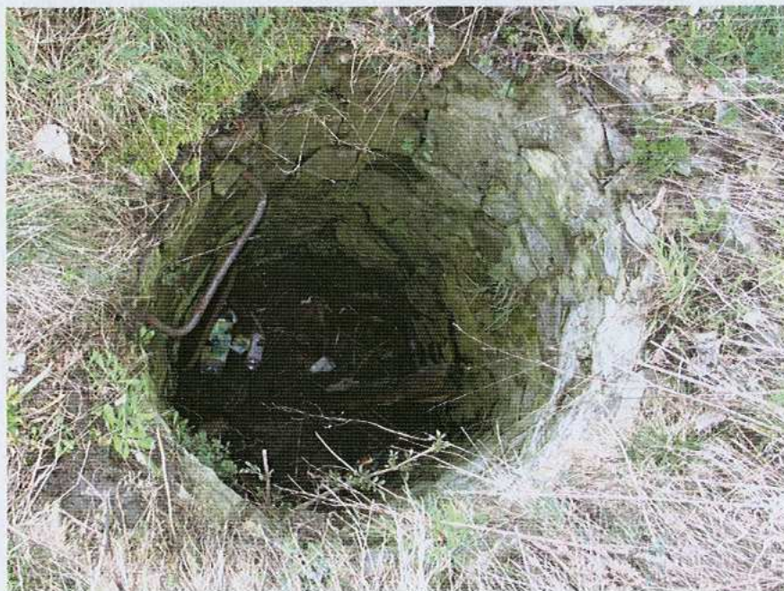
Studnia wentylacji kopuły- wtórna
