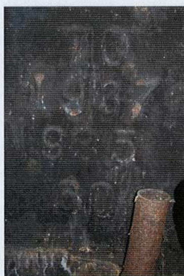
Rura czerpni powietrza, widoczne zniszczenia korozyjne
