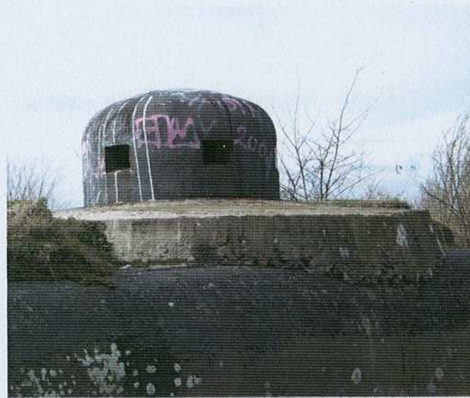
Opaska betonowa kopuły obserwacyjnej
