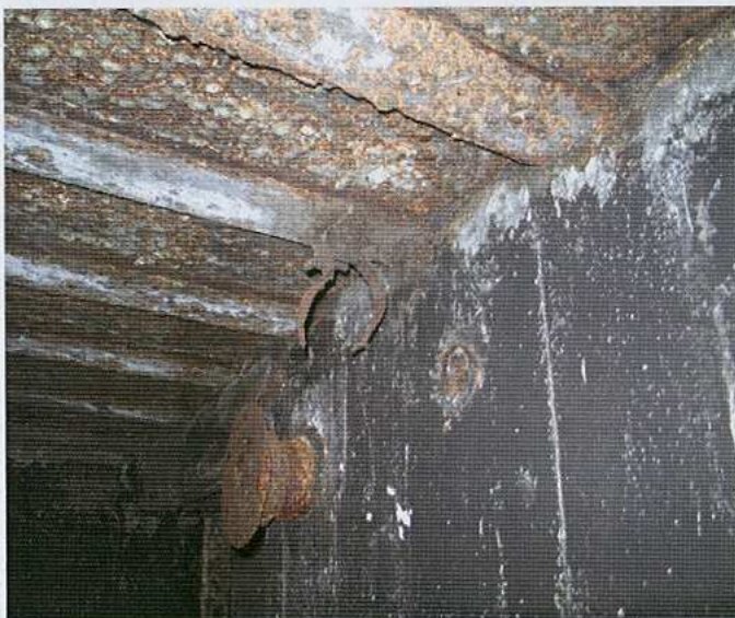
Uchwyty inst. went. widoczne zniszczenia korozyjne
