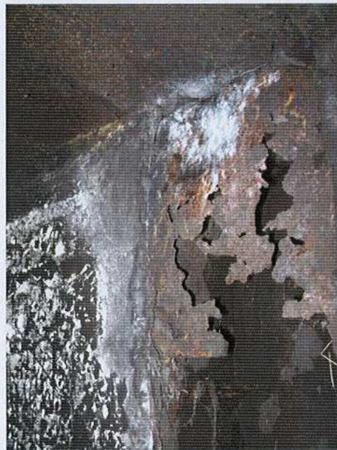
Rura czerpni powietrza, widoczne zniszczenia korozyjne
