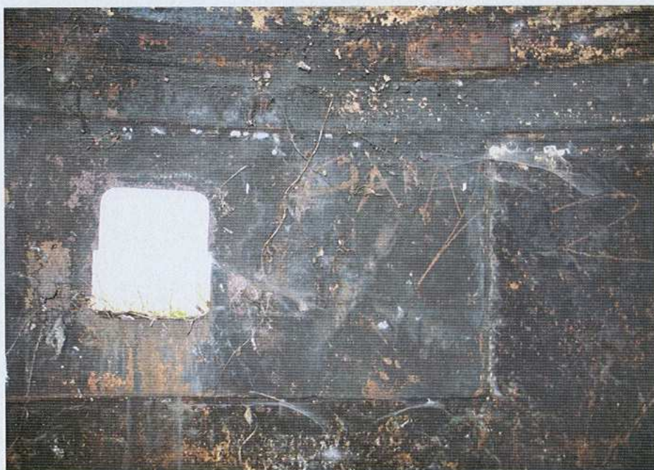
Uchwyty inst. went. widoczne zniszczenia korozyjne
