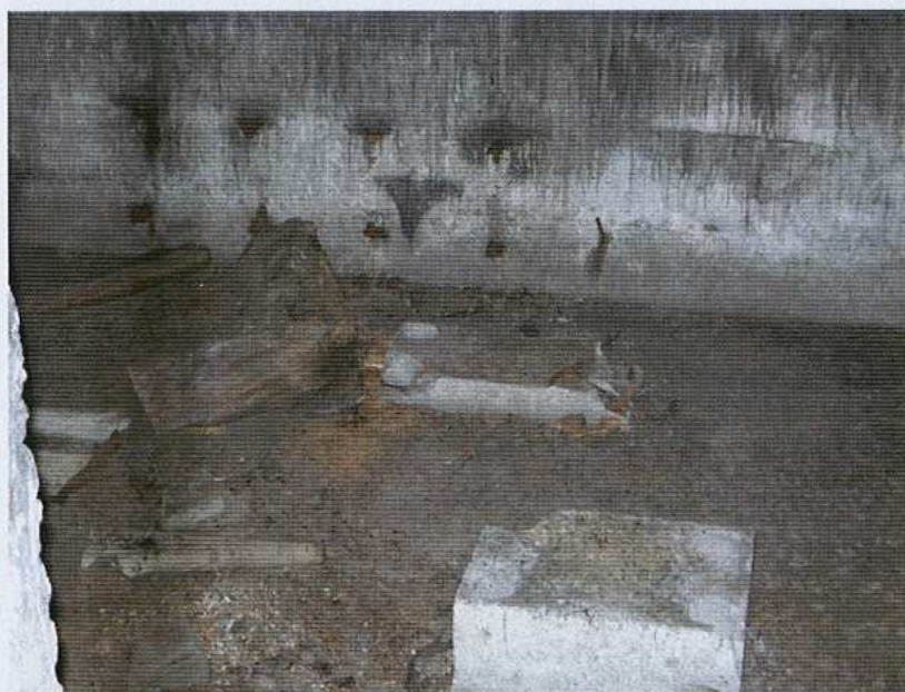
Maszynownia –postumenty pod silnik i agregat
