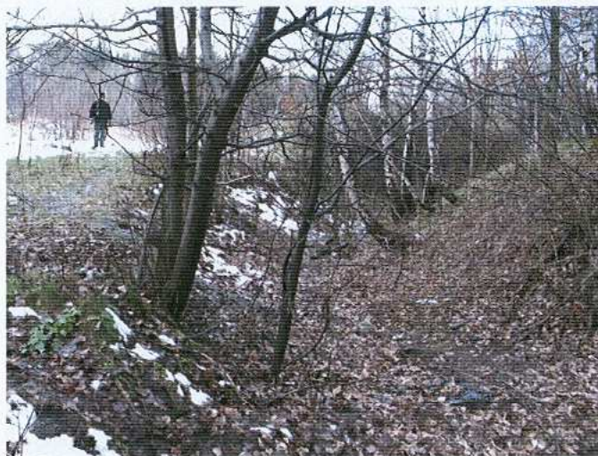
Droga dojazdowa w wykopie
