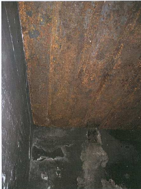
Strop przeciwoodpryskowy i otwór wentylacji
