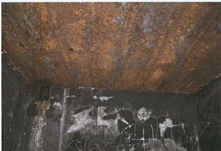
Komora amunicyjna- strop
