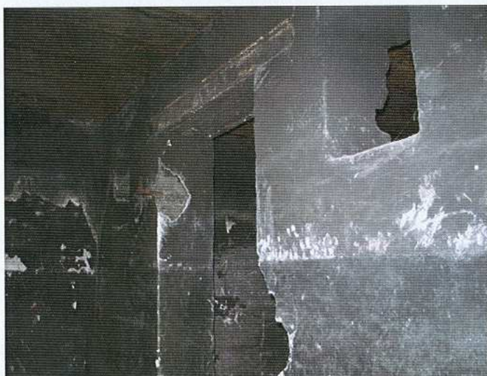
Wejście z korytarza do komory amunicyjnej
