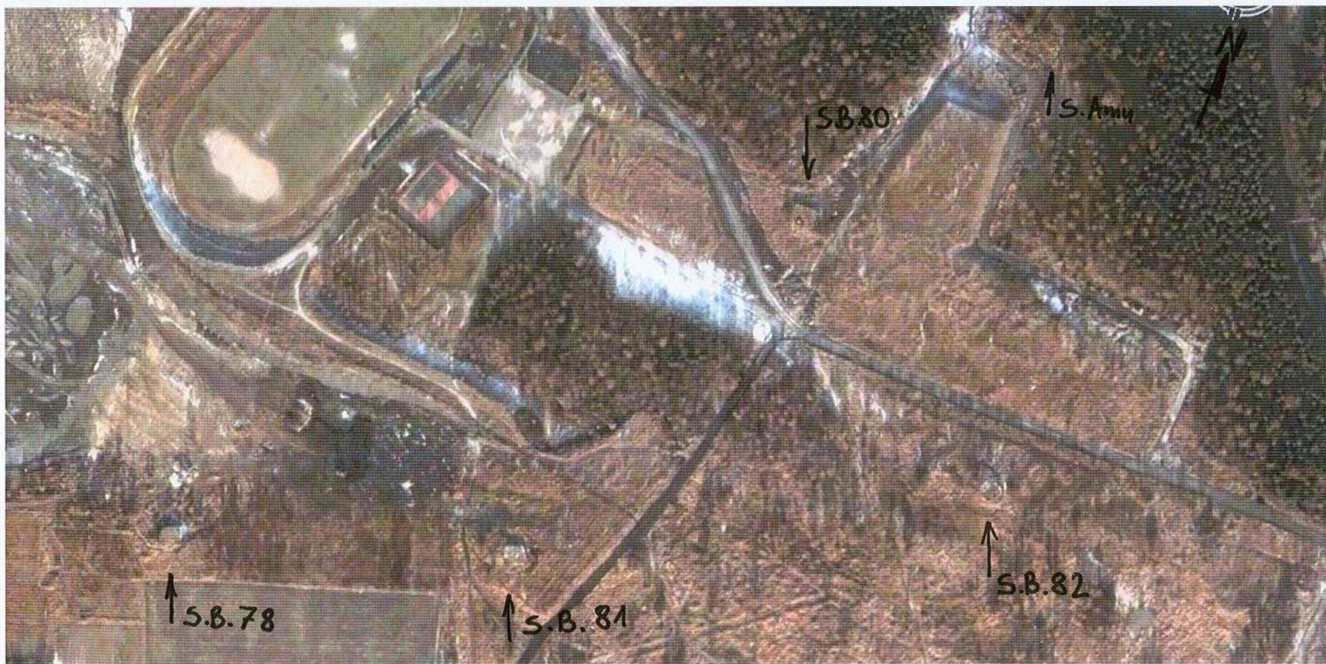
Fragment terenu PO Radoszowy z obiektami 78.80,81,80 i schronem amunicyjnym
