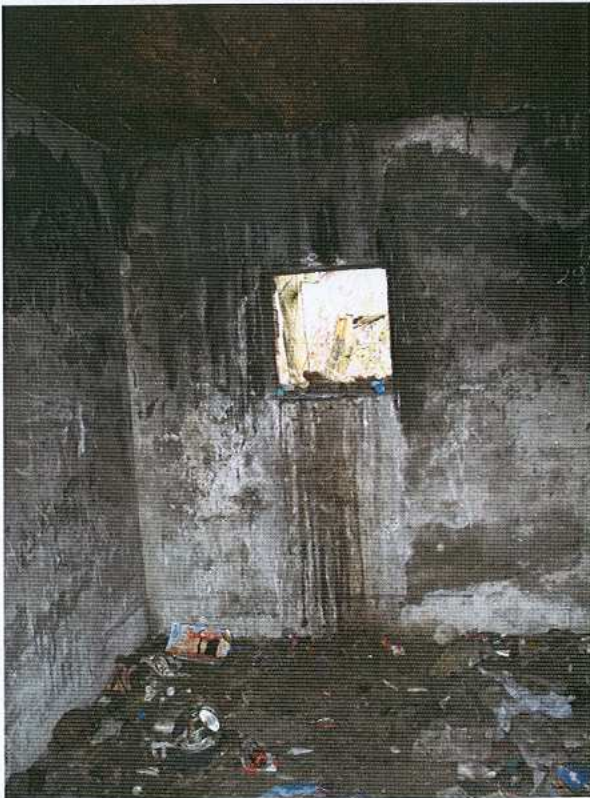
Komora wyjściem zapasowym
