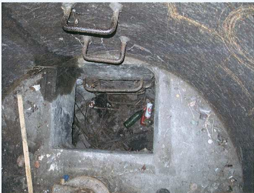
Wejście do kopuły
