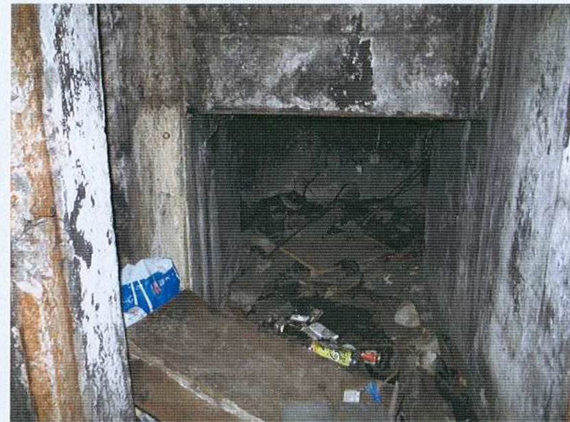
wejście do szybu kopuły
