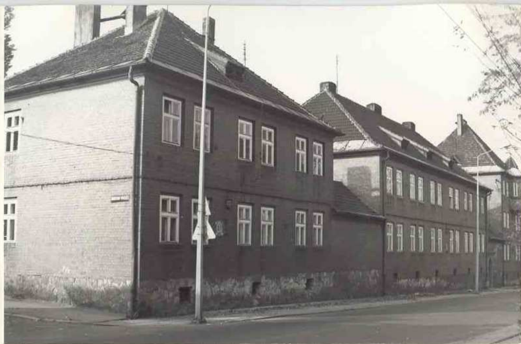
12. Ul. Wolności - budynki nr 35 i 37
