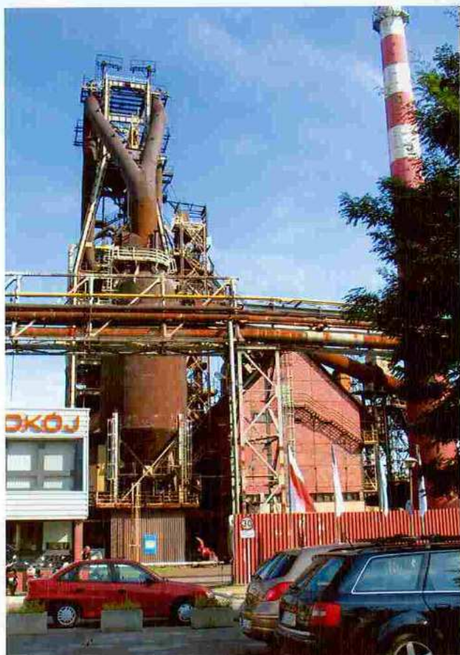
WIDOK ZESPOŁU WIELKIEGO PIECA „A” OD STRONY PD. NA PIERWSZYM PLANIE ODPYLNIAK STATYCZNY ORAZ BUDYNEK PRZEPOMPOWNI, FILTRÓW I PRZETWORNICY
