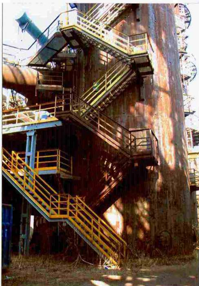
Widok konstrukcji schodów nagrzewnicy nr 1 przy podstawie. Widok od strony południowej
