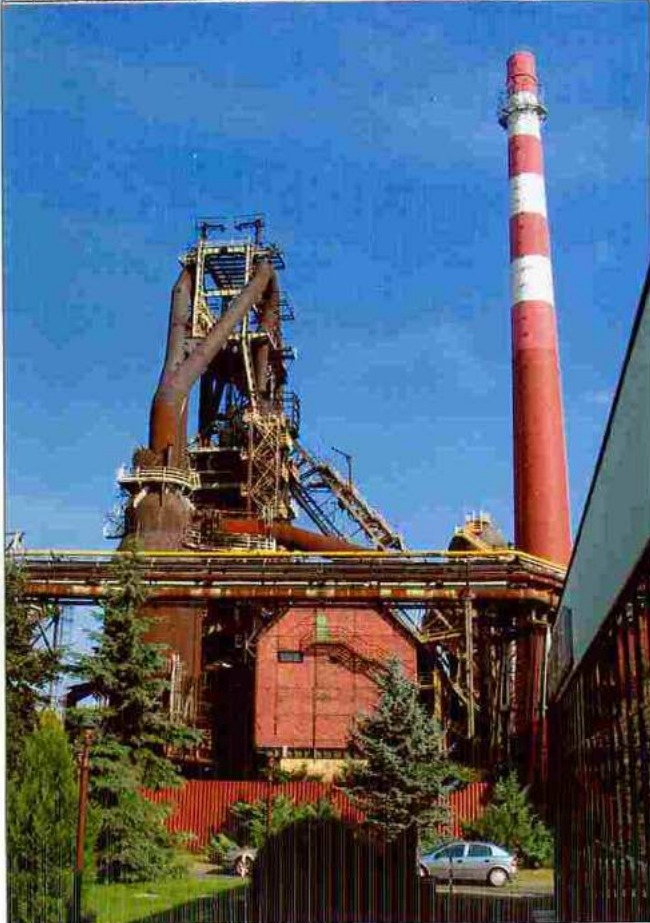
Widok wielkiego pieca „A” wraz z odpylnikiem statycznym, budynkiem filtracji, przepompowni i przetwornic od strony Pd
