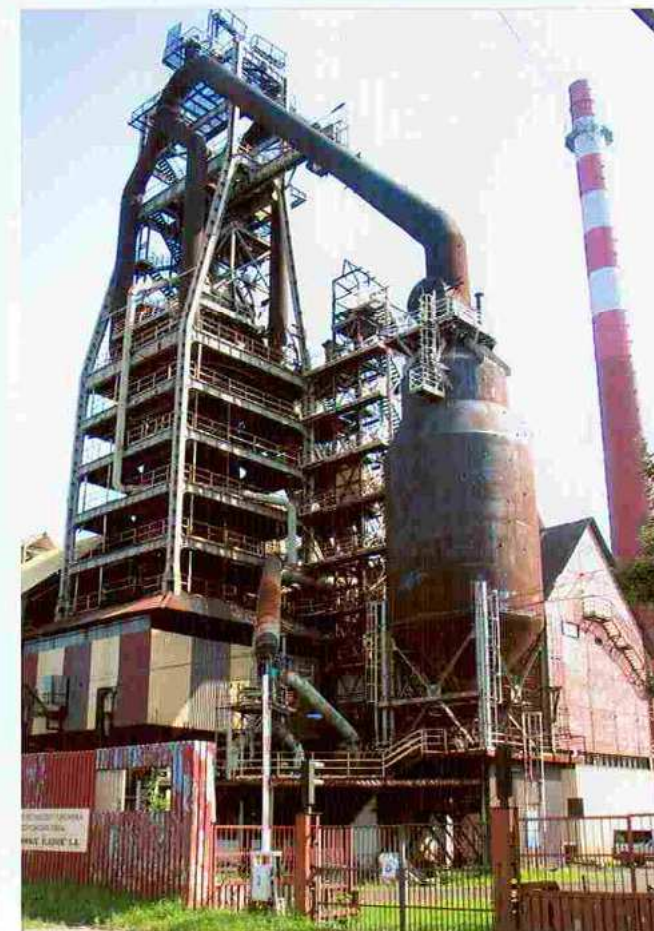
WIDOK ZESPOŁU WIELKIEGO PIECA „A” OD STRONY PD-ZACH.
