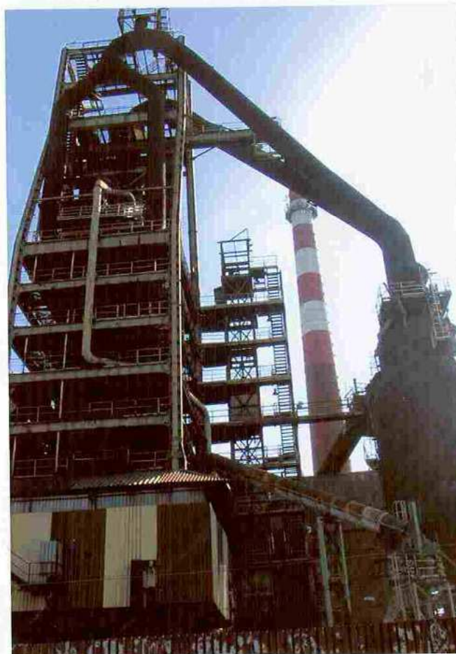
WIDOK ZESPOŁU WIELKIEGO PIECA „A” OD STRONY ZACH.
