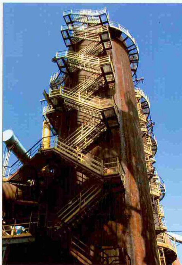
Widok konstrukcji schodów nagrzewnicy nr 1 w górnej części. Widok od strony południowej
