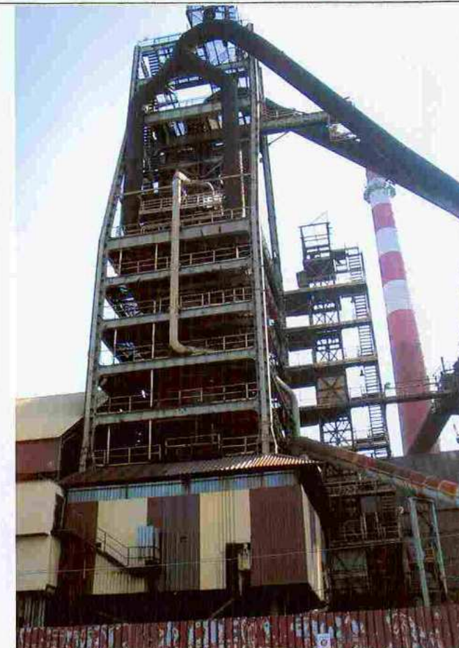
Widok wielkiego pieca „A” od strony Zach.
