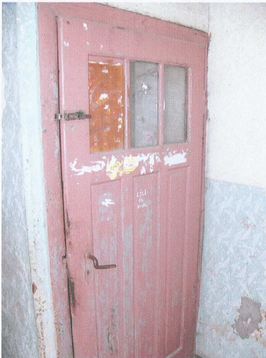
34. Stolarka drzwiowa. Piwnica
