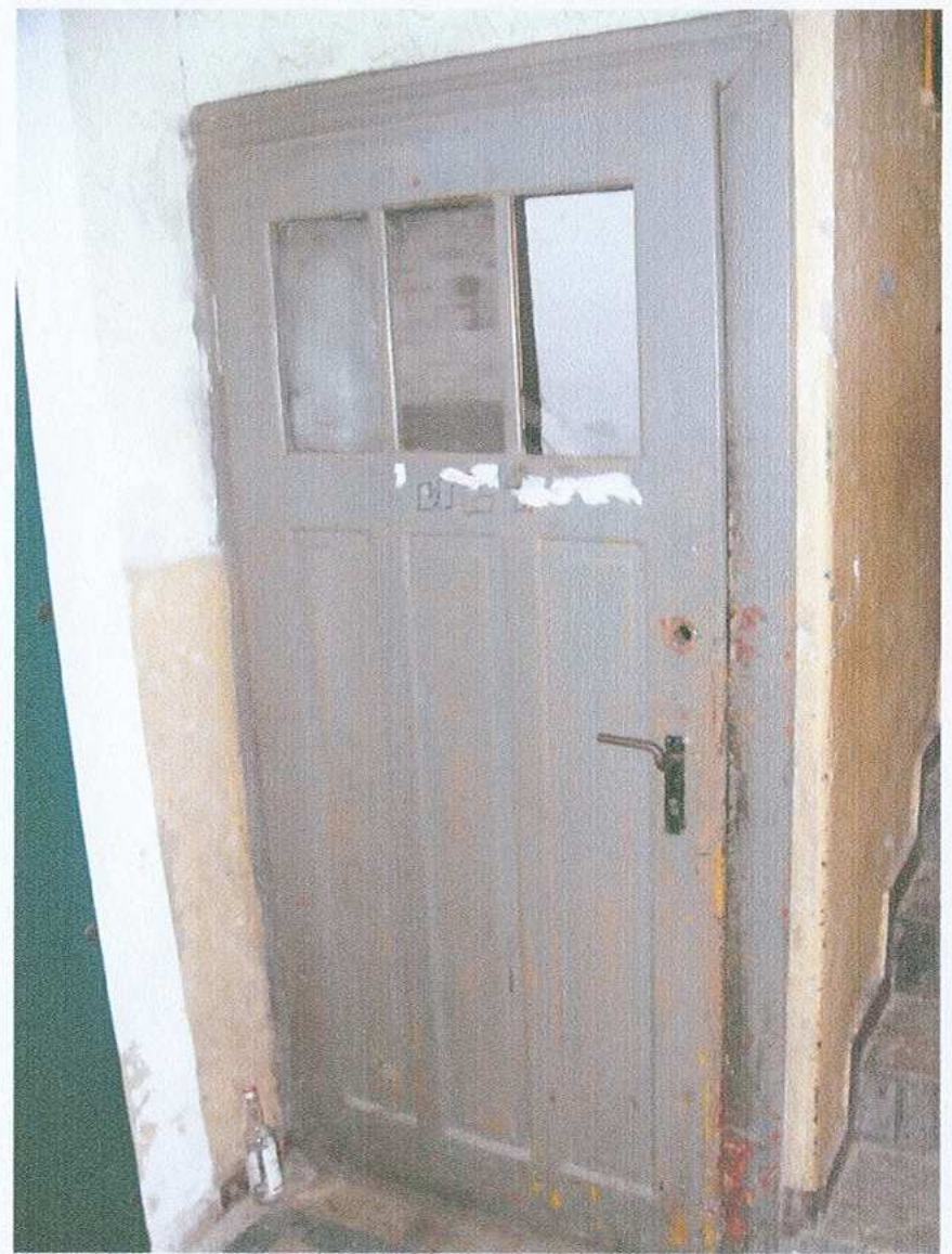
17. Klatka schodowa. Piwnica
