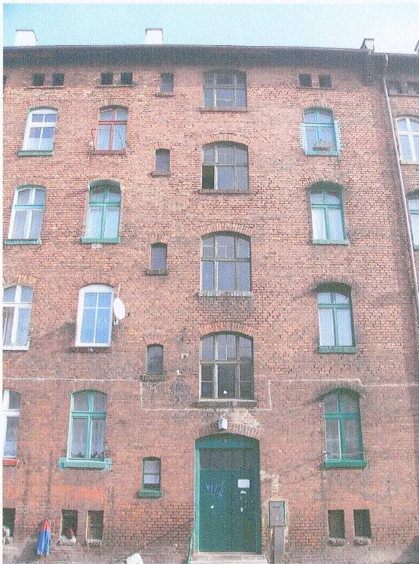
Trzon zasadniczy budynku. Fragment elewacji zachodniej
