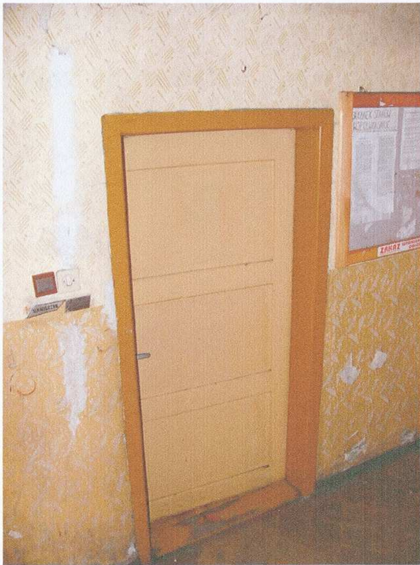
65. Stolarka drzwiowa. Klatka schodowa
