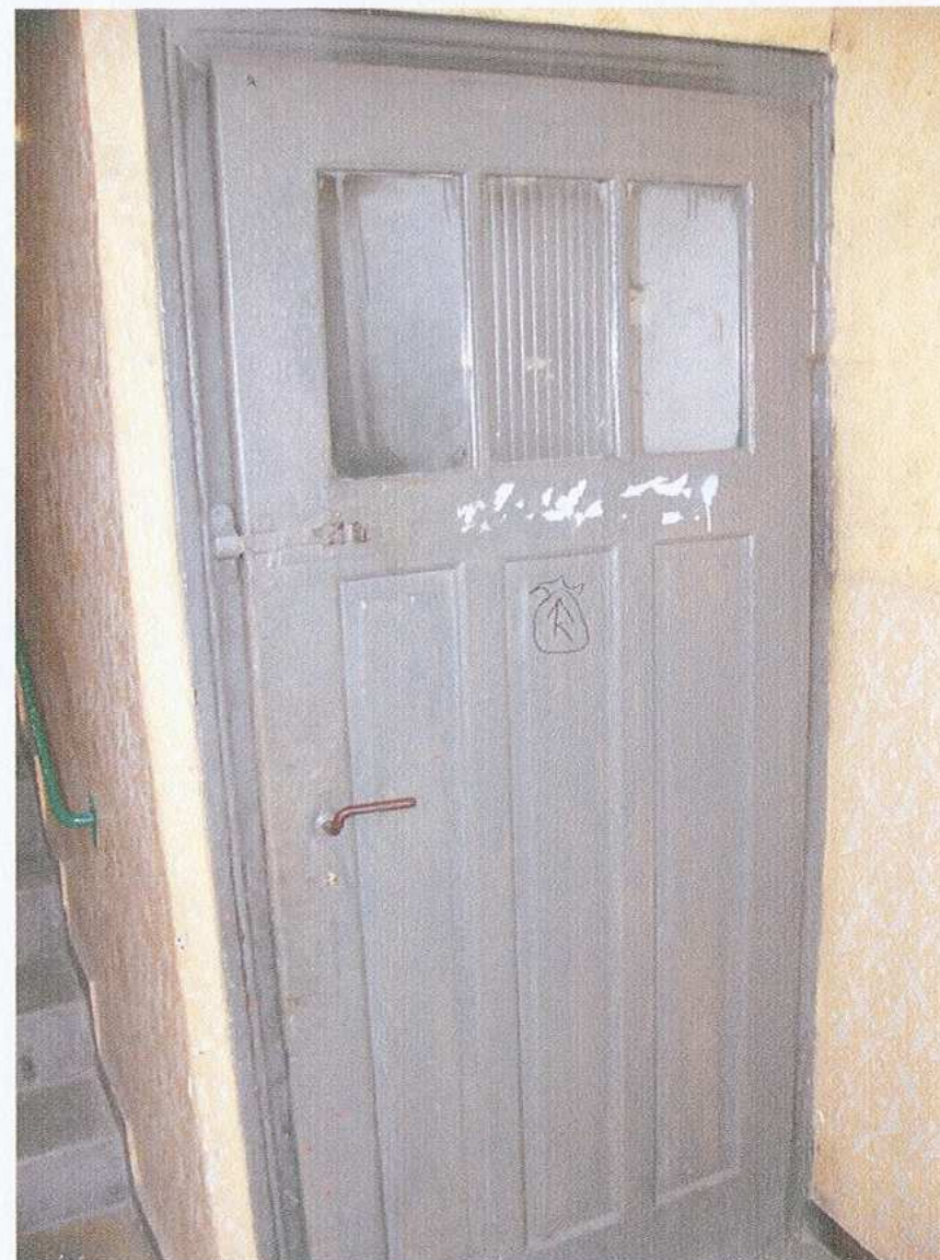
52. Stolarka drzwiowa. Piwnica
