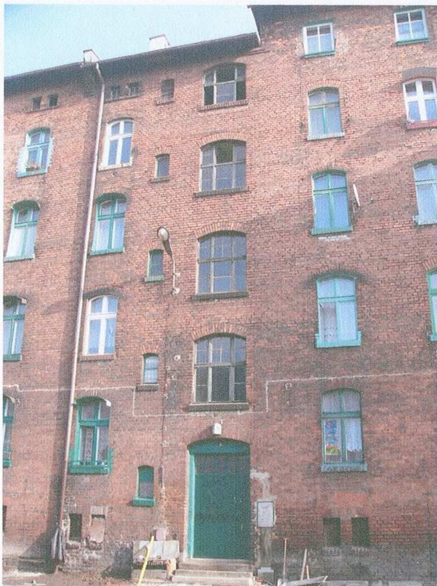
Trzon zasadniczy budynku. Fragment elewacji zachodniej
