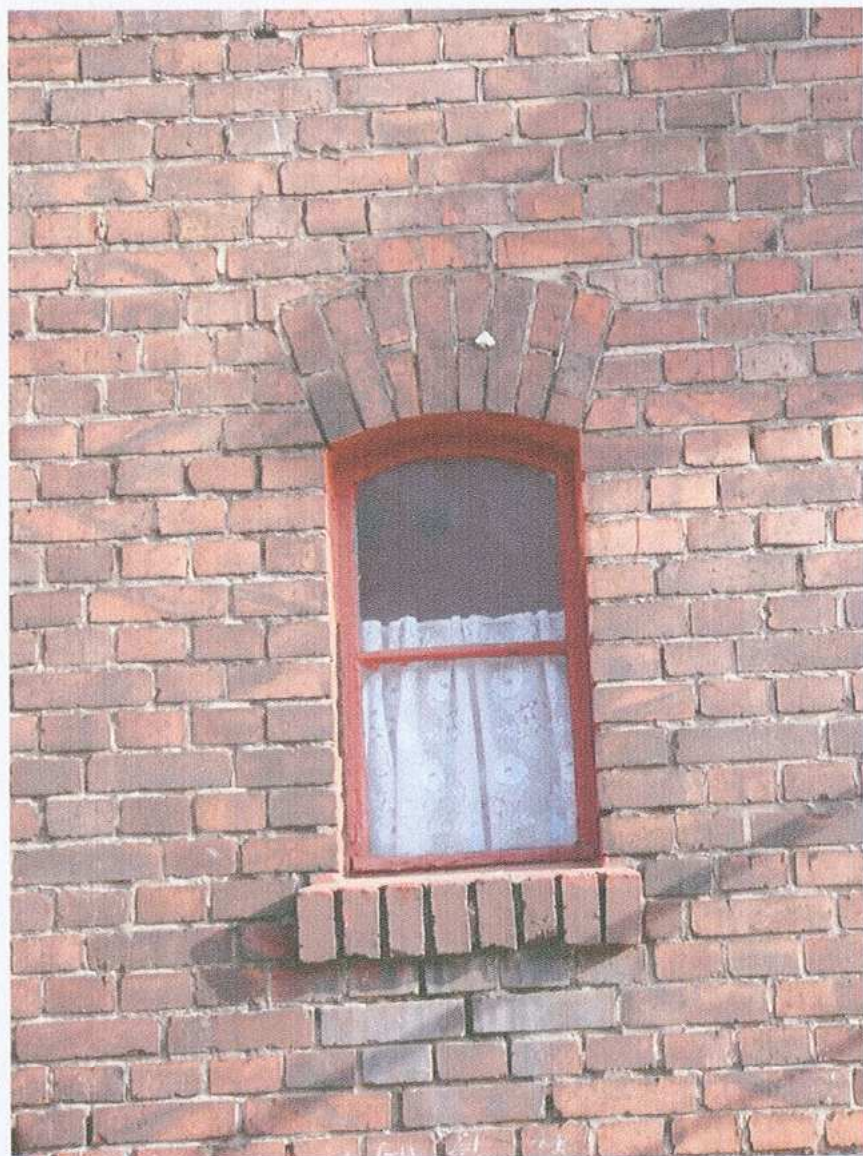
58. Trzon zasadniczy budynku. Fragment elewacji zachodniej. Okno
