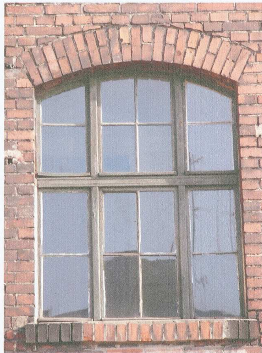
55. Trzon zasadniczy budynku. Fragment elewacji zachodniej. Okno
