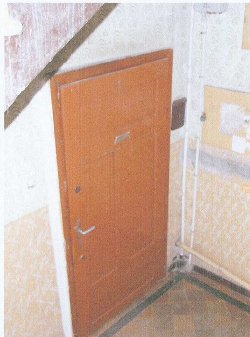
48. Klatka schodowa. Stolarka drzwiowa
