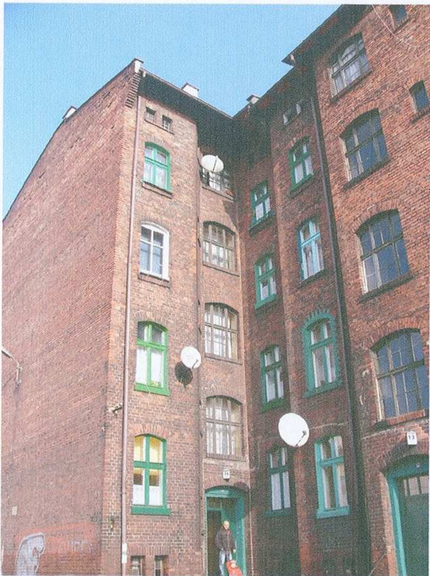
59. Skrzydło północne. Widok od południowego - zachodu
