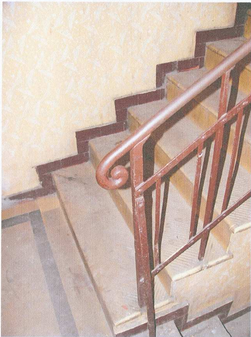
25. Klatka schodowa. Bariera
