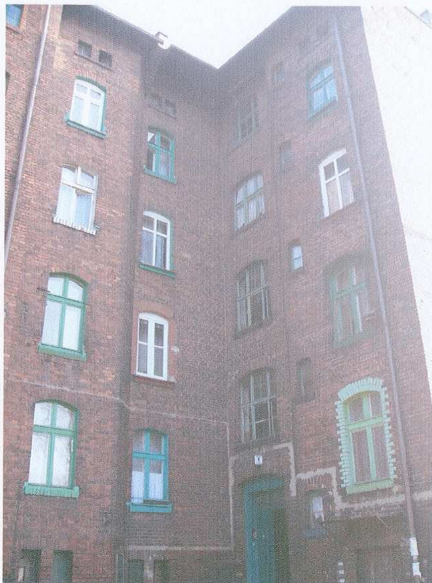
14. Skrzydło południowe budynku. Elewacja północna
