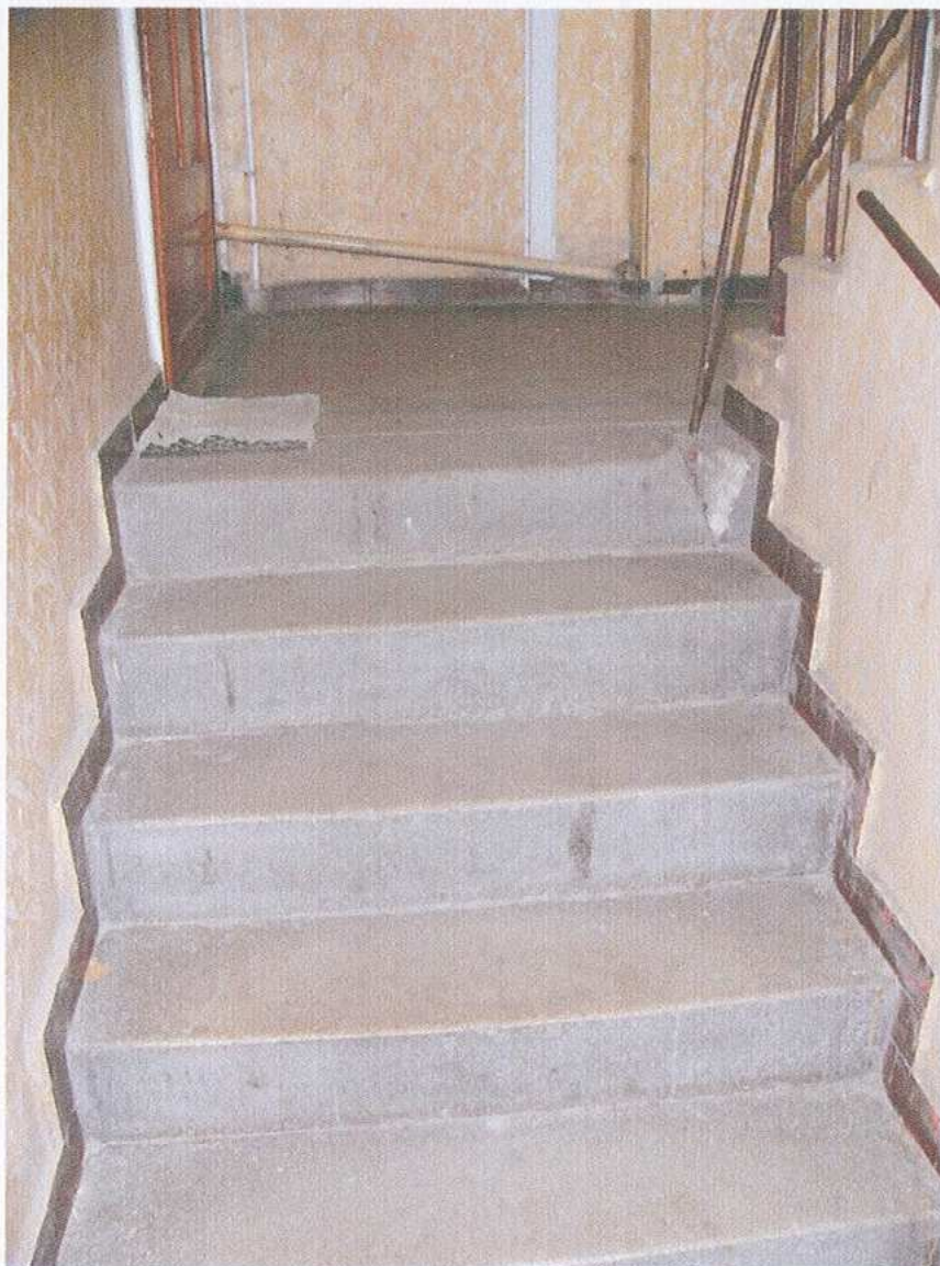
47. Klatka schodowa. Widok ogólny
