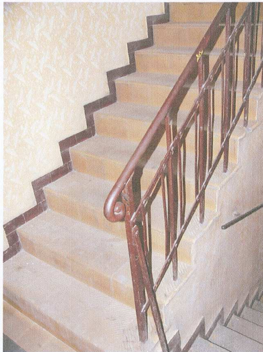
46. Klatka schodowa. Bariera
