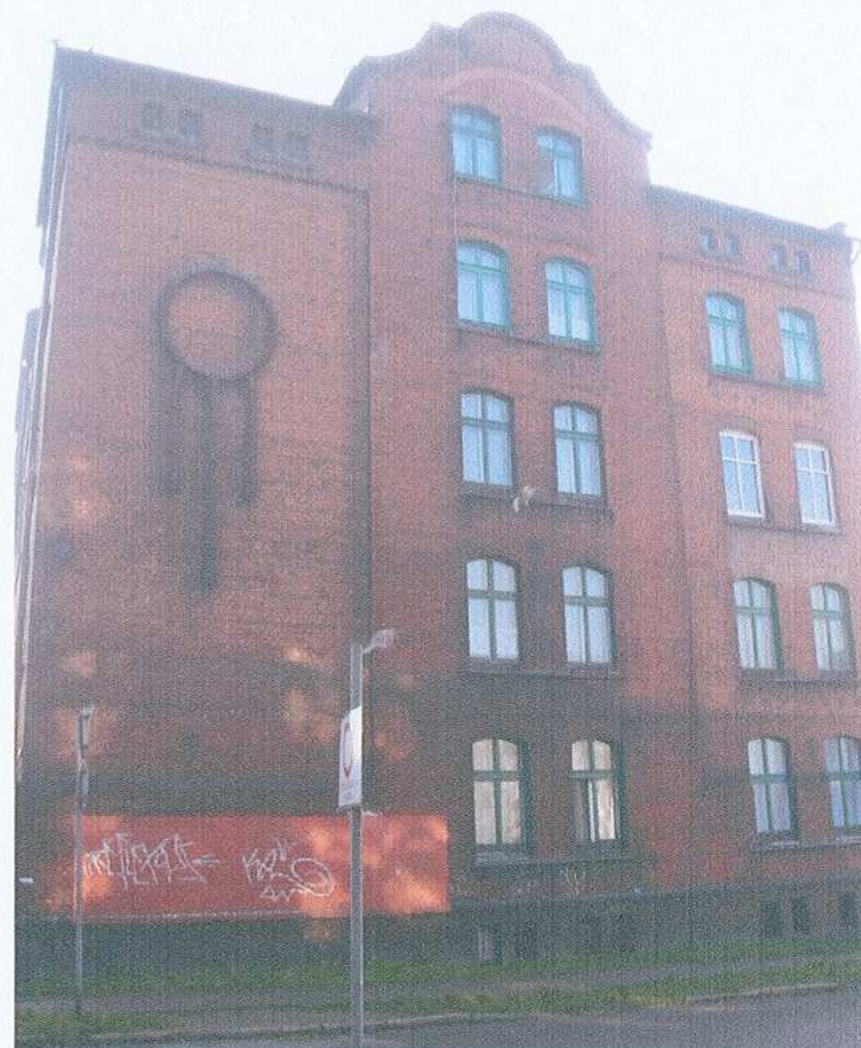
4. Skrzydło północne. Elewacja północna
