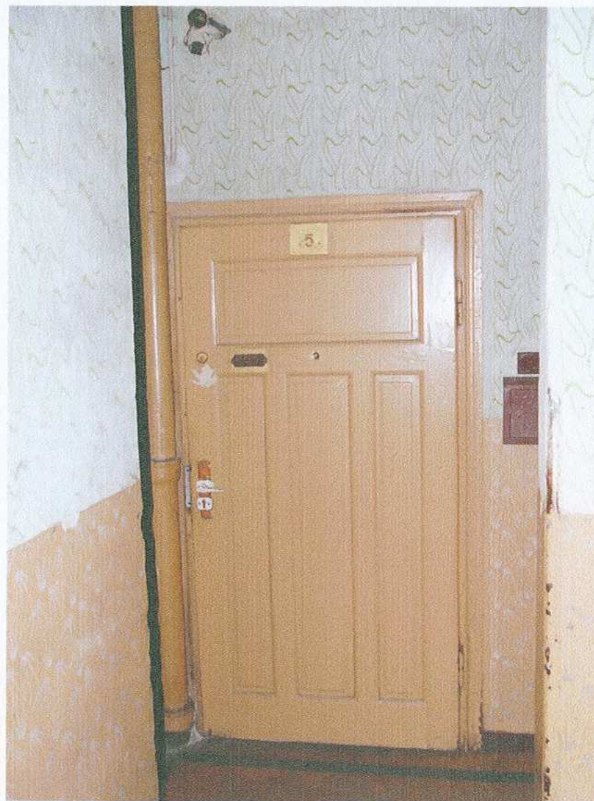
21. Klatka schodowa. Stolarka drzwiowa
