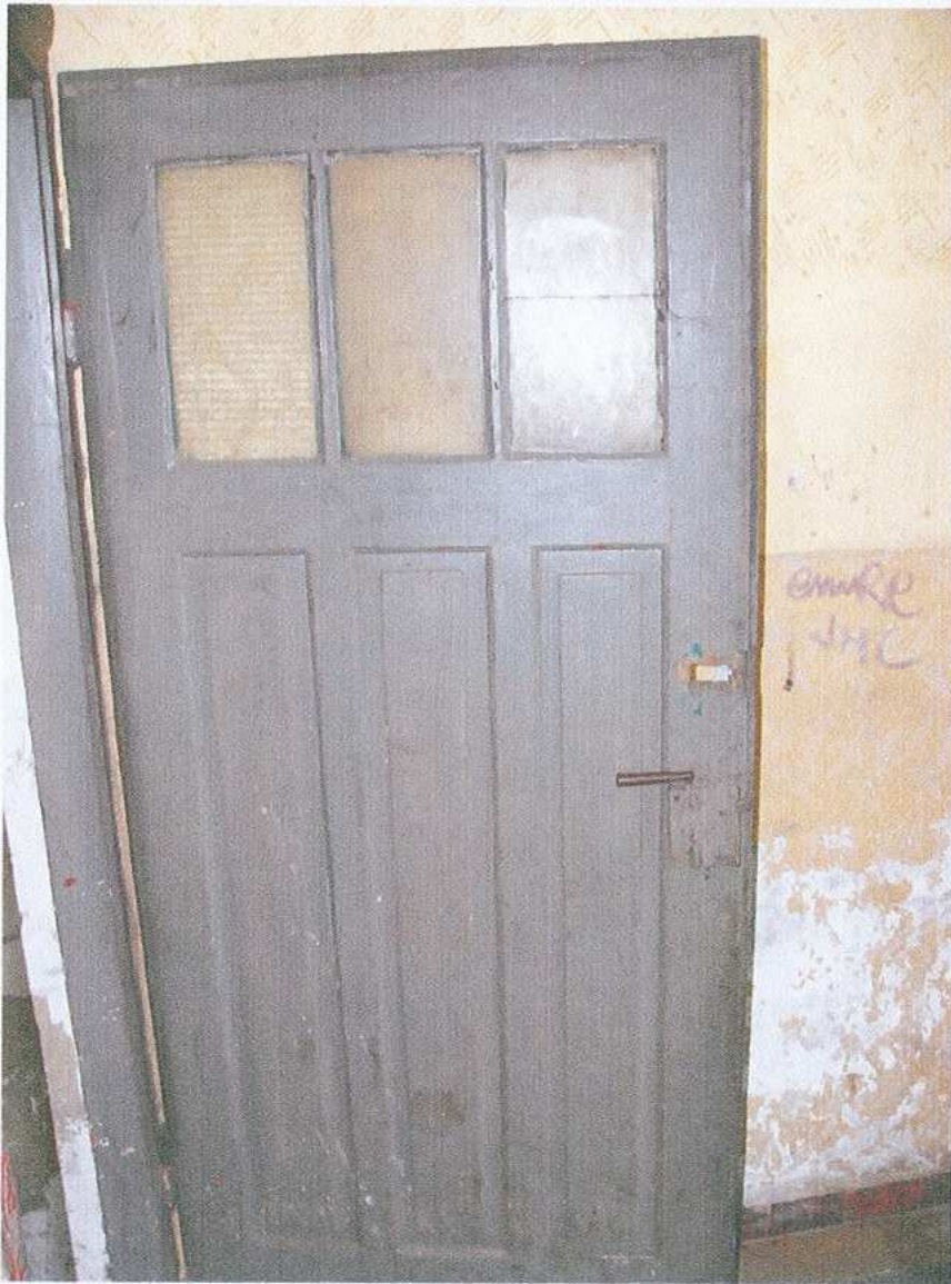
27. Stolarka drzwiowa. Piwnica
