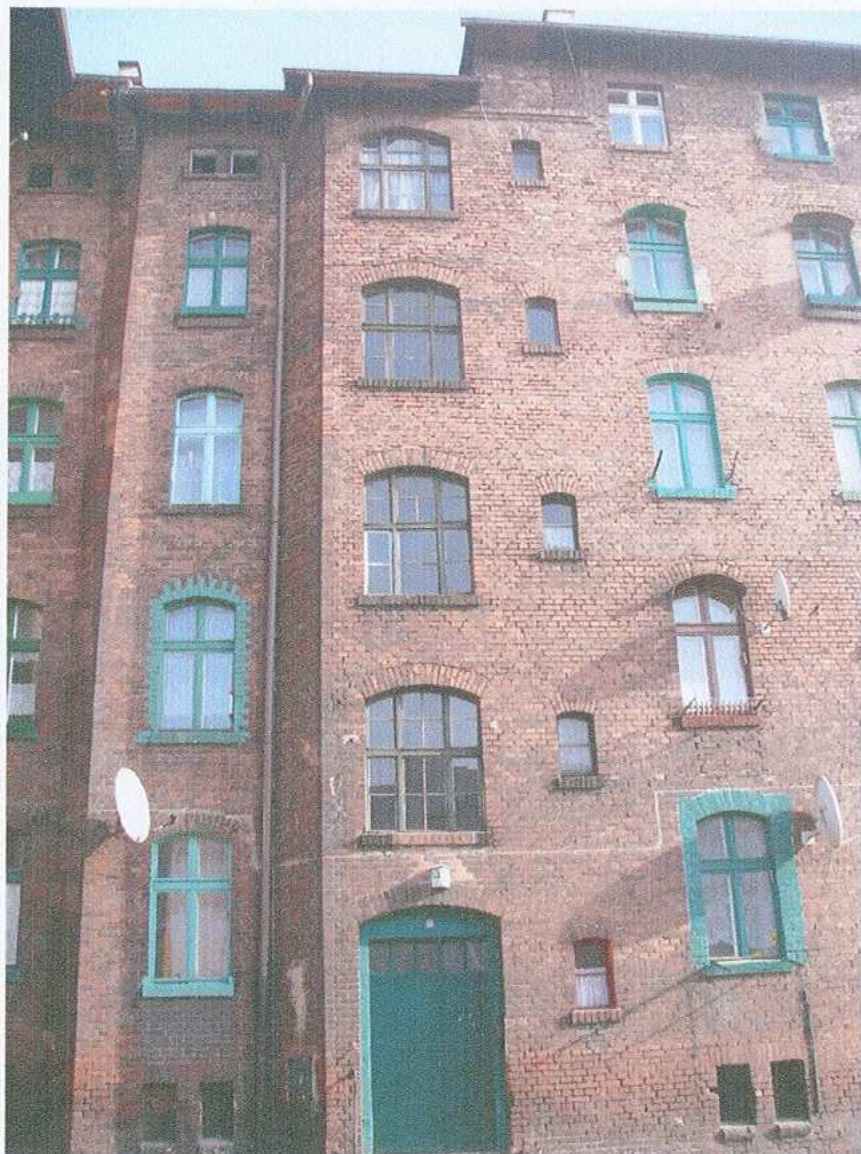
54. Trzon zasadniczy. Fragment elewacji zachodniej
