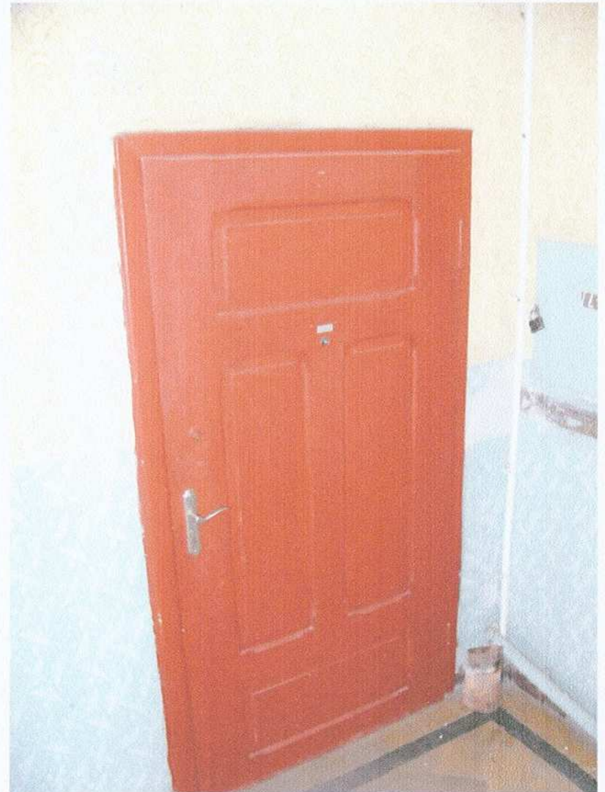
42. Klatka schodowa. Stolarka drzwiowa
