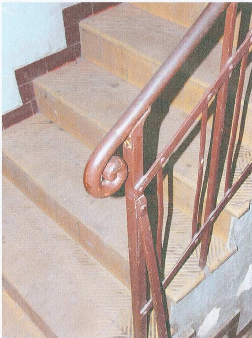
32. Klatka schodowa. Bariera
