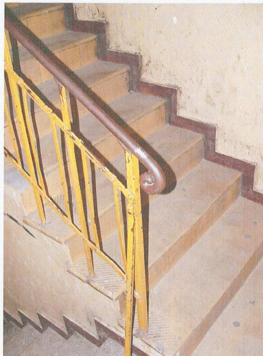
19. Klatka schodowa. Bariera
