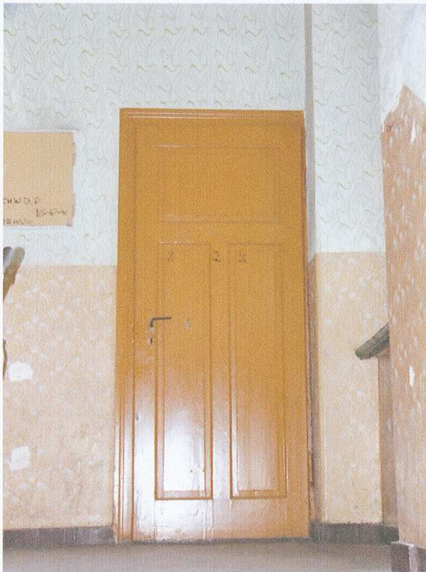
22. Klatka schodowa. Toaleta
