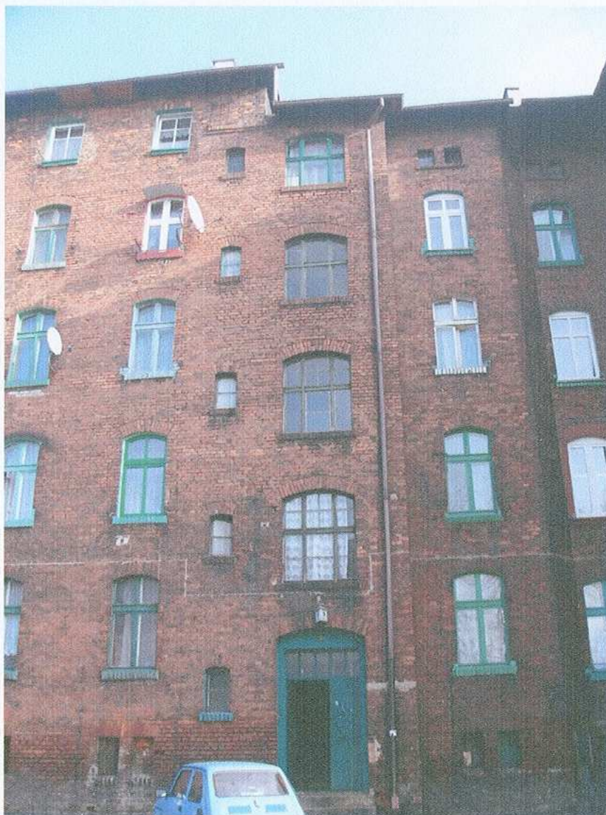
Trzon zasadniczy budynku. Fragment elewacji zachodniej
