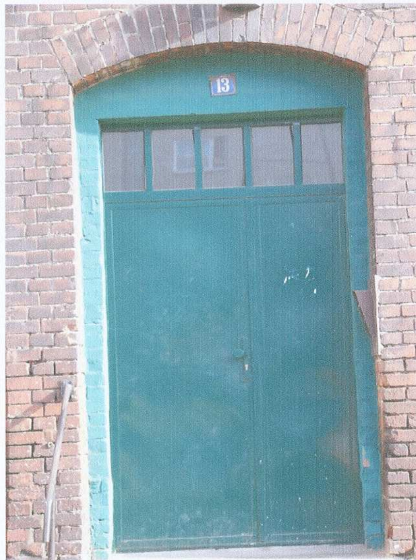
57. Trzon zasadniczy budynku. Fragment elewacji zachodniej. Drzwi wejściowe
