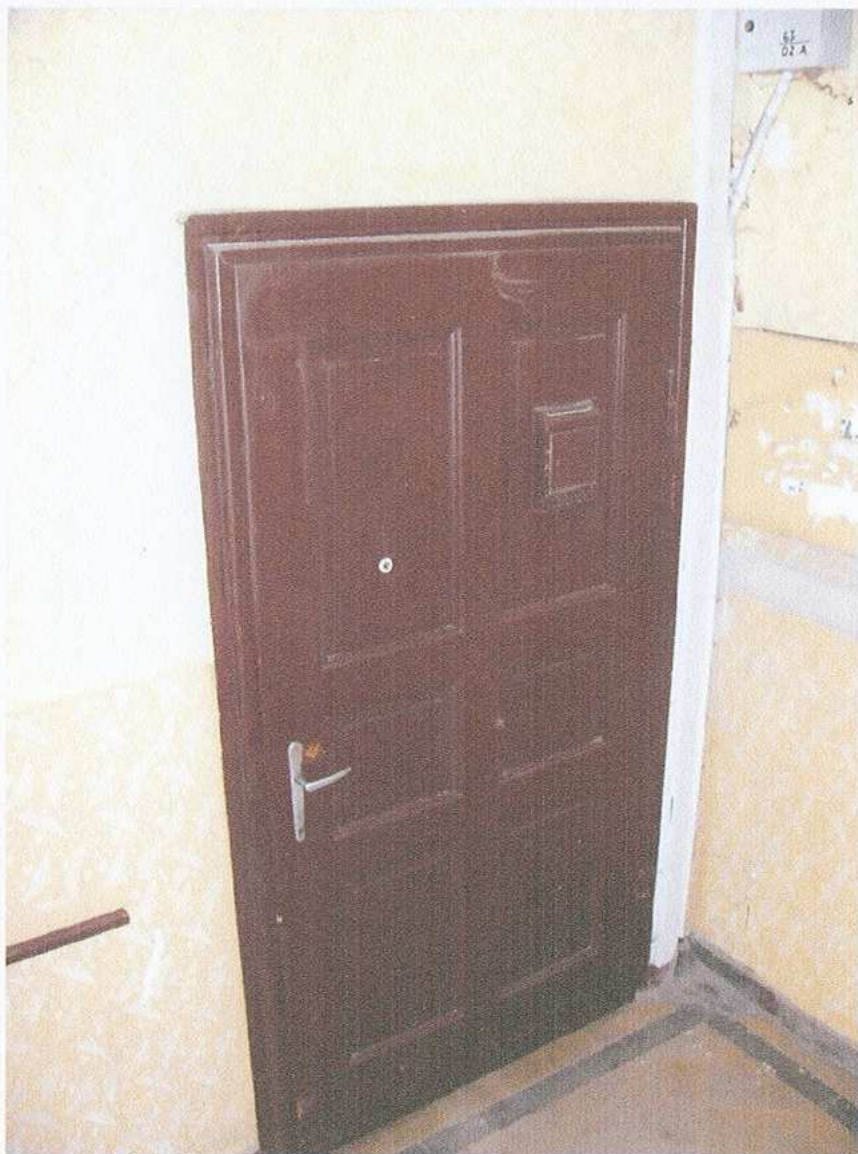
29. Klatka schodowa. Stolarka drzwiowa
