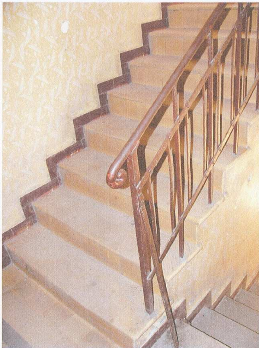
63. Klatka schodowa. Bariera
