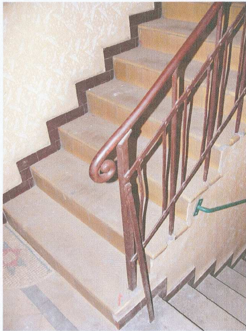
50. Klatka schodowa. Bariera
