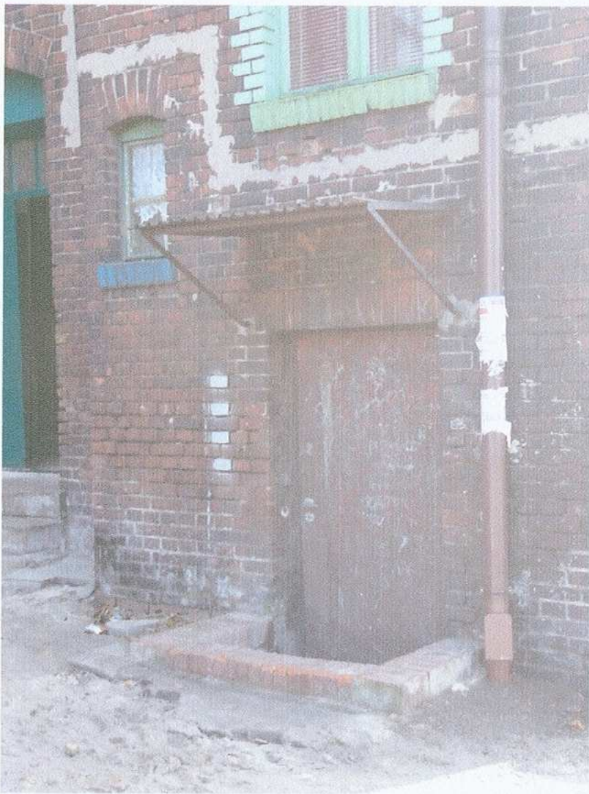
16. Skrzydło południowe. Fragment elewacji północnej
