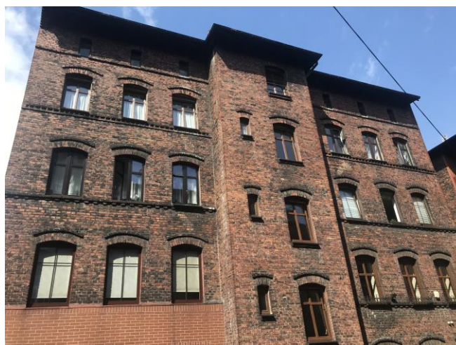
elewacja wschodnia budynku oficyny
