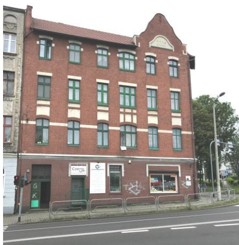
Elewacja północno-wschodnia budynku
