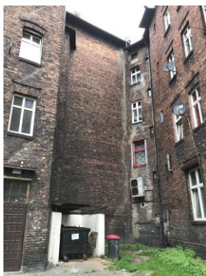
Tylna elewacja budynku
