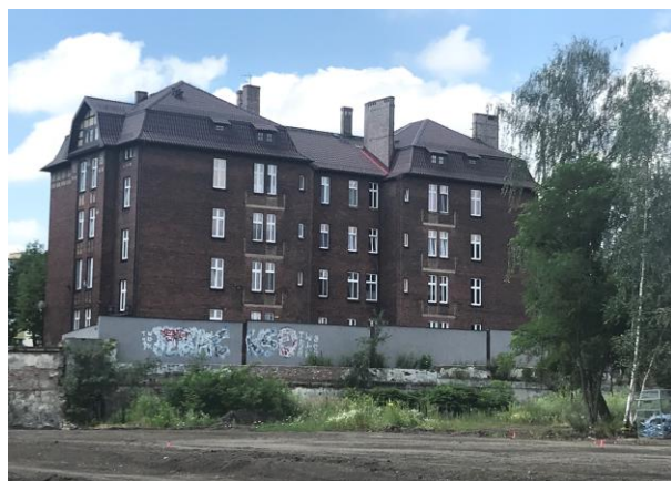
elewacja północna budynku
