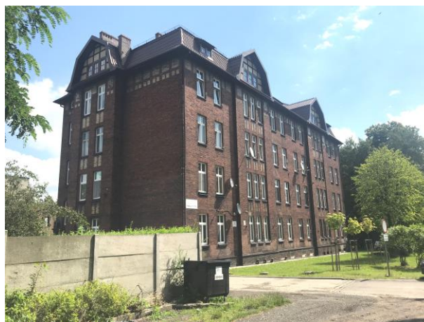
widok z południowego-zachodu
