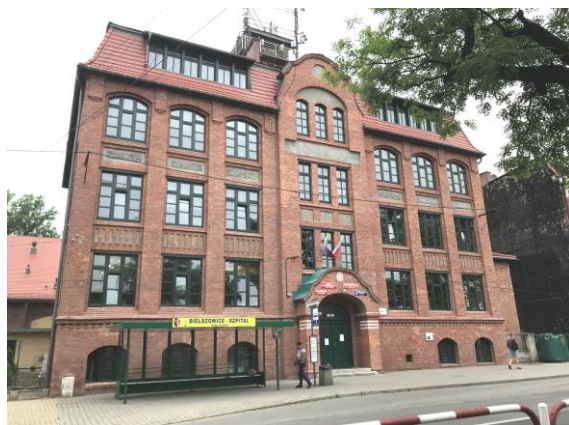
Elewacja frontowa budynku
