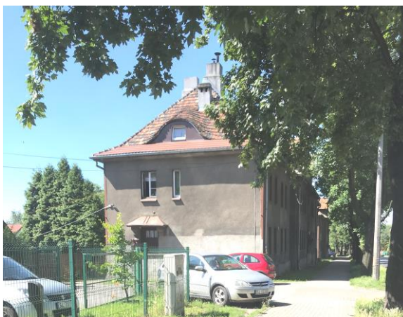
Elewacja północno-wschodnia budynku
