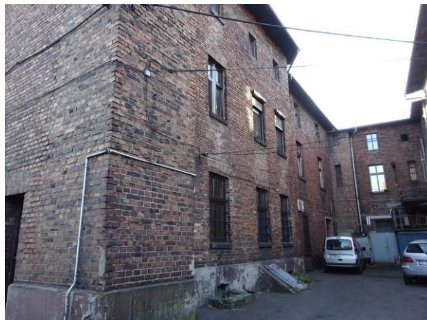
Widok od strony północno wschodniej
