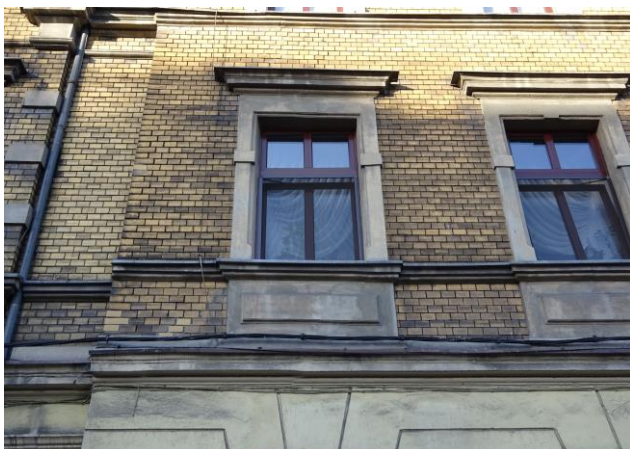
Detal elewacji frontowej
