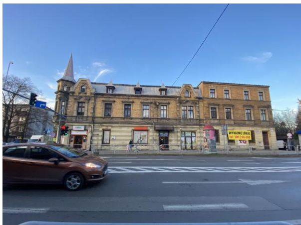
Elewacja frontowa budynku
