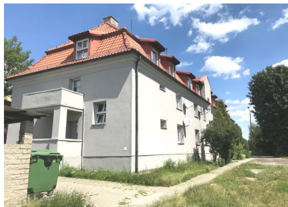
Widok z południowo-zachodu
