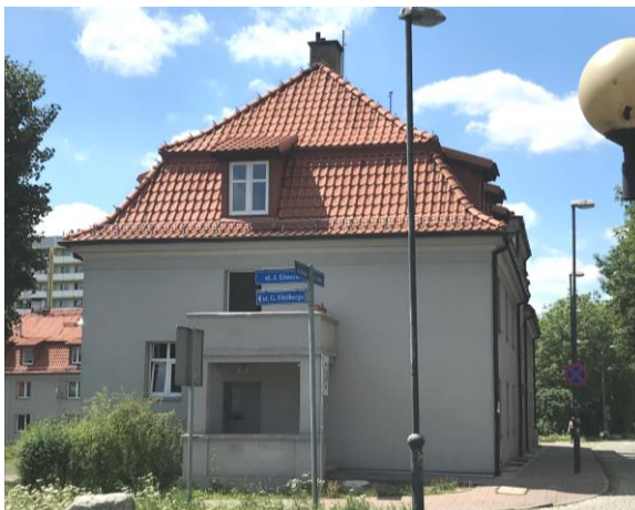
Elewacja wschodnia budynku
