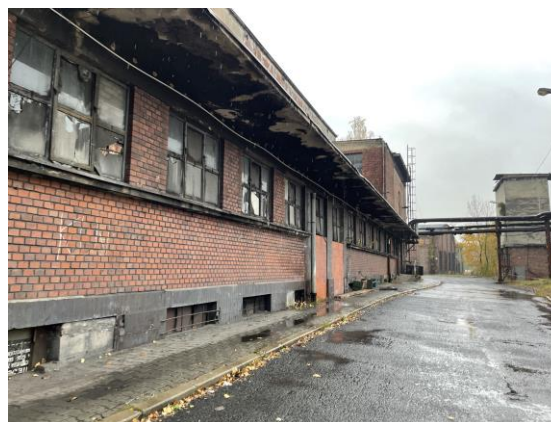
Elewacja wschodnia - widok od południa
