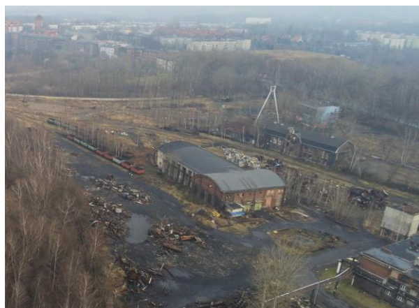
Widok na budynek od strony południowego zachodu
