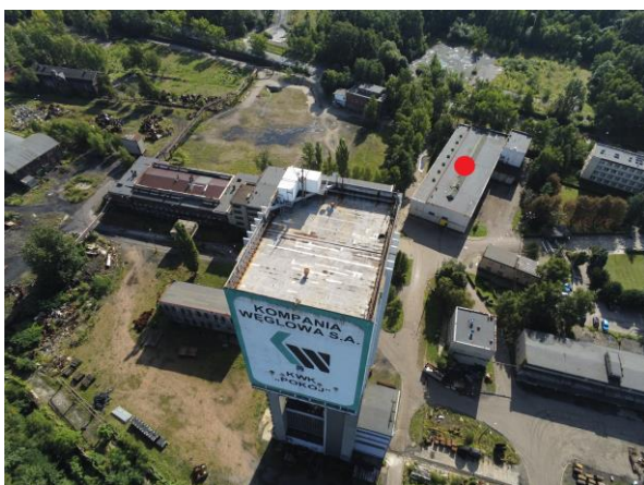
Widok na budynek od strony zachodniej
