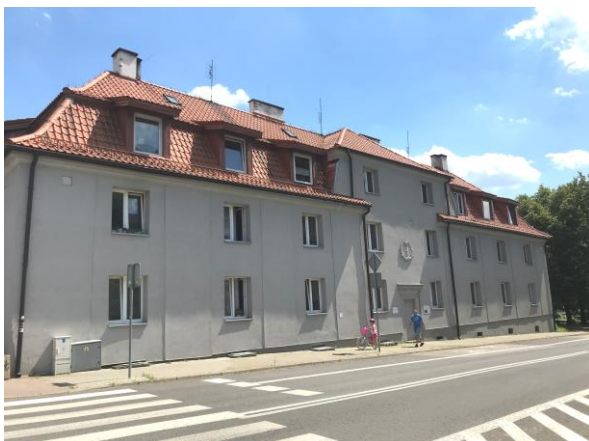
Elewacja frontowa budynku
