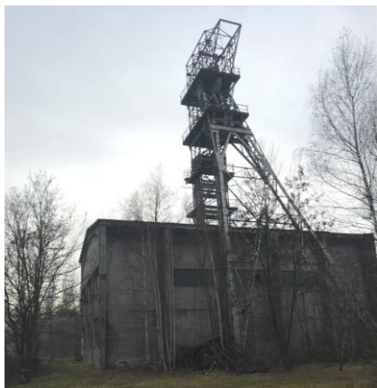
Nadszybie z wieżą wyciągową
