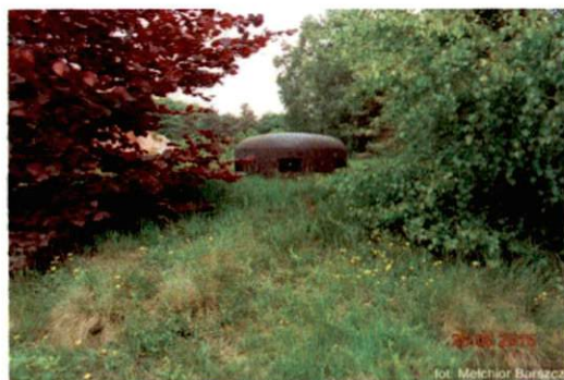
Zdjęcie nr 116. Widok od południa kopuła pancerna
