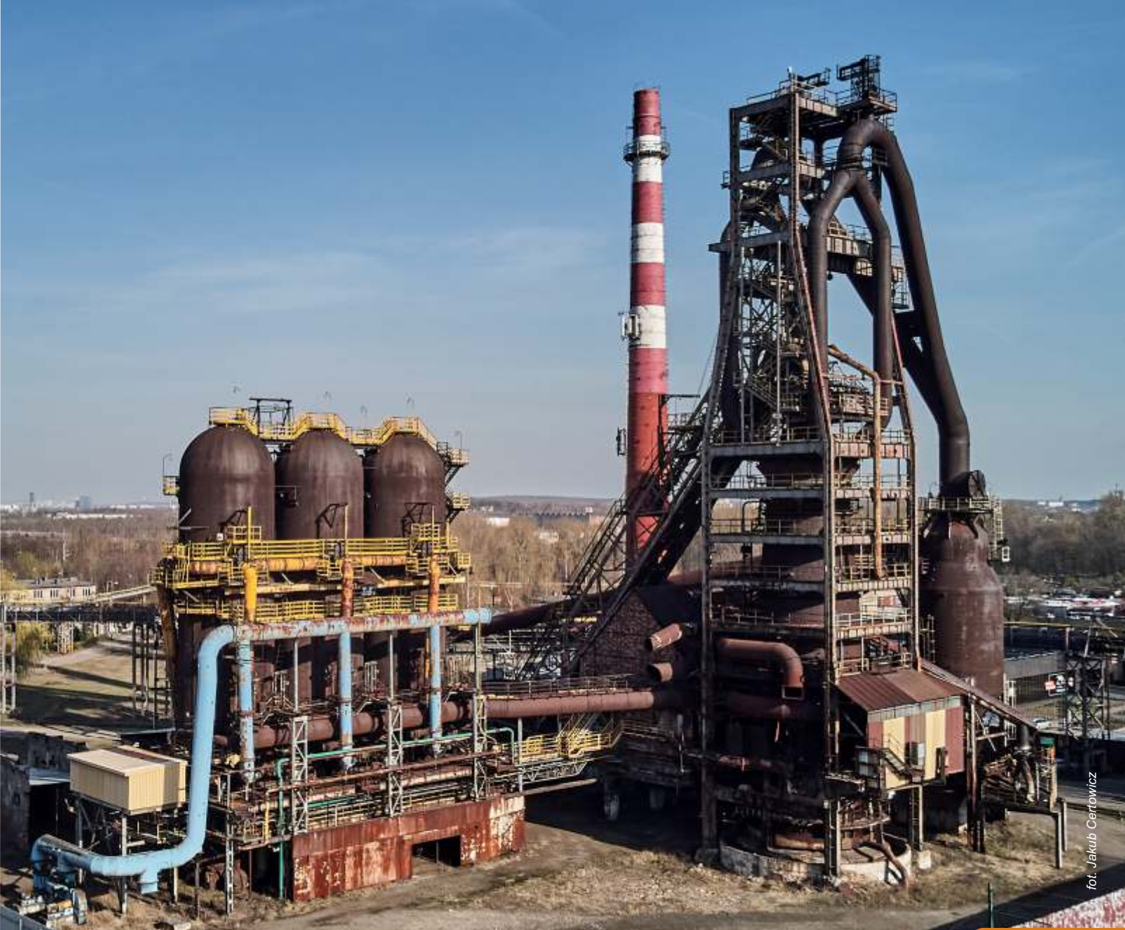
Zespół Wielkiego Pieca „A”. Blast Furnace „A” complex.
