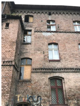
Elewacja tylna budynku
