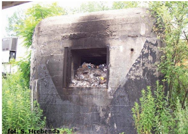
widok obiektu od wschodu
