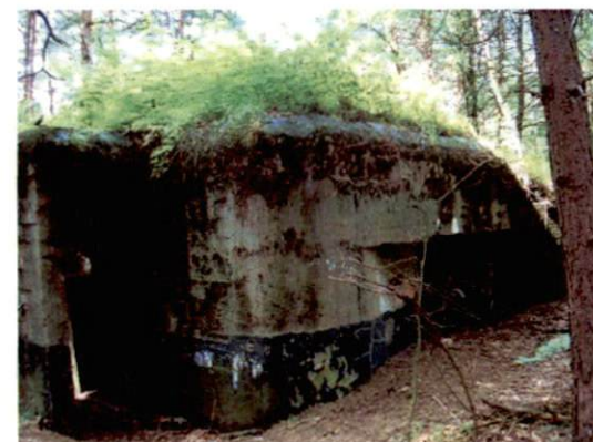
Zdjęcie nr 118. Widok od północnego-wschodu
